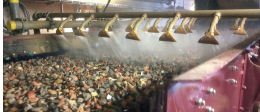
RC-Kiesaufbereitung | Sieb- und Waschanlage
