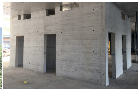
Treppenhaus aus NovoCon Sichtbeton
